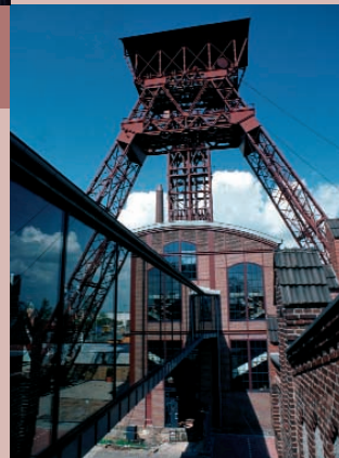
Das restaurierte Fördergerüst.
