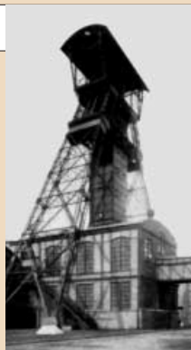
Das Doppelstrebengerüst mit Schachthalde.
